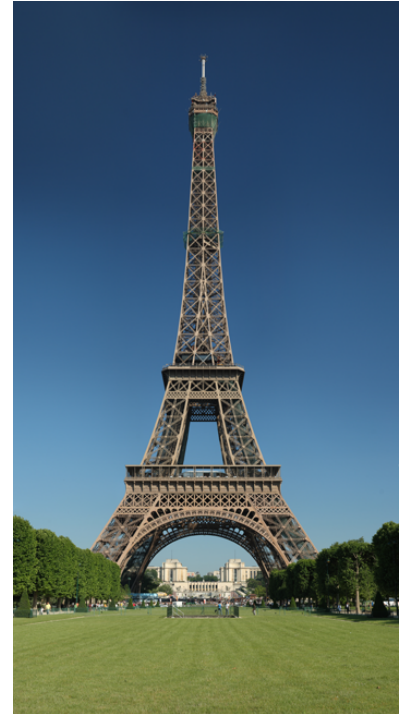
Am Eiffelturm in Paris sind regelmässige Beschichtungsarbeiten zwingend
