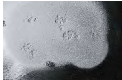
Ein Rostnest muss noch gestrahlt werden, dann ist die behandelte Stelle fertig.
