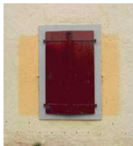
Fensterladen zu, und schon erkennt man, welchen Ton die Fassade ursprünglich hatte.
