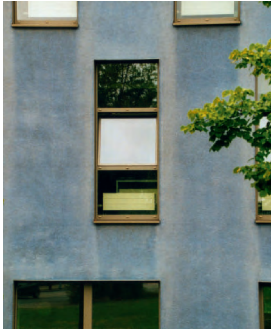
Farbtonveränderung wegen zu geringer Lichtbeständigkeit und Kreidung (Fotos zu diesem Beitrag: iba-INSTITUT, Düsseldorf, Koblenz, Stuttgart)
