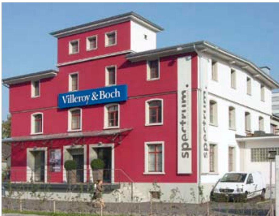
Gebäude von Villeroy & Boch in Lenzburg: Die roten Flächen wurden mit Exposan Top, die weissen Flächen mit Exposit-Silicon-Mineralfarbe von Bosshard ausgeführt.
